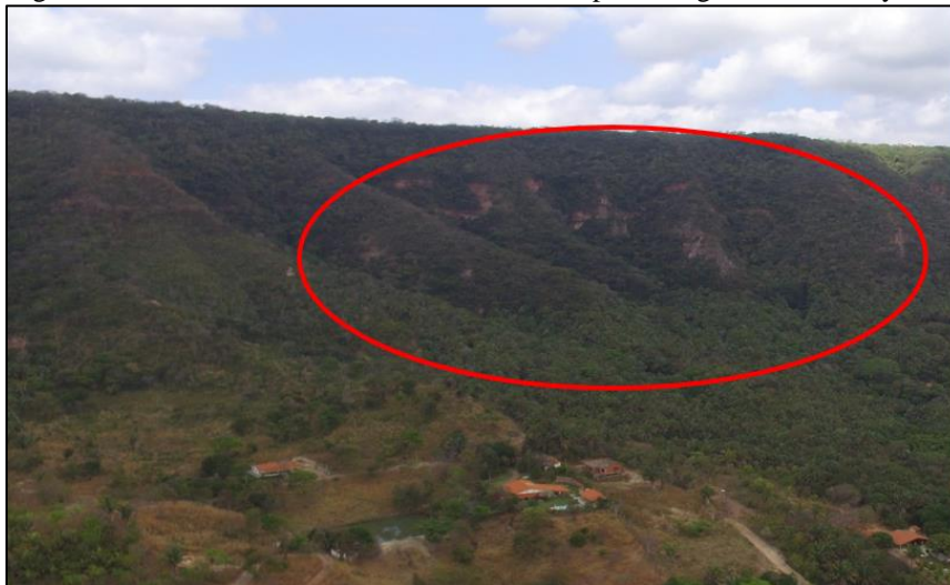
Figura 5 - Presença de cicatrizes de escorregamentos na região de escarpa da área de estudo. Figure 5 - Presence of landslide scars in the escarpment region of the study area.
